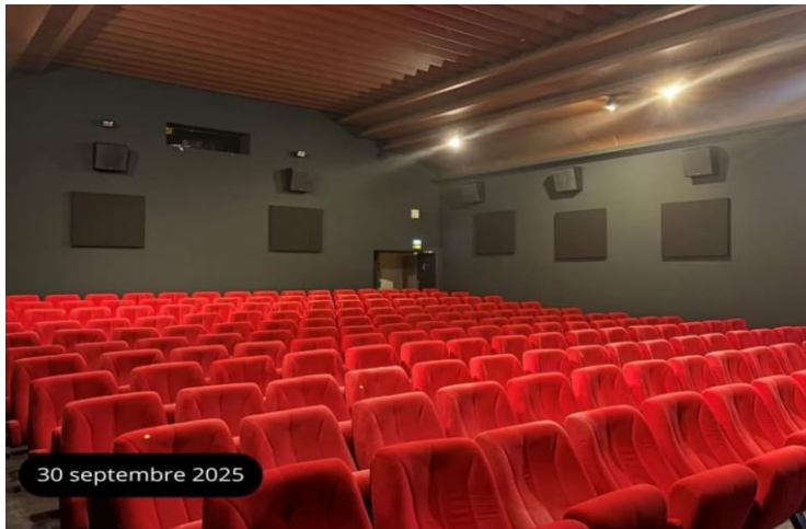
Poursuite des travaux de requalification du cinéma municipal « Le Palace »
