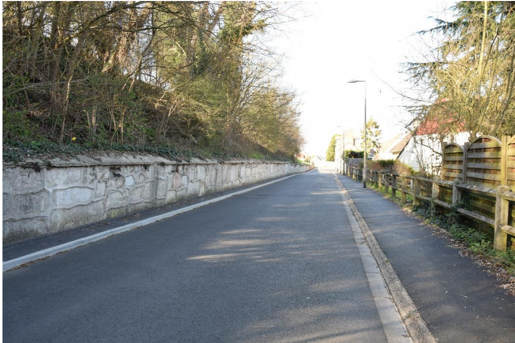
Première tranche de la rue Villers-Saint-Frambourg
