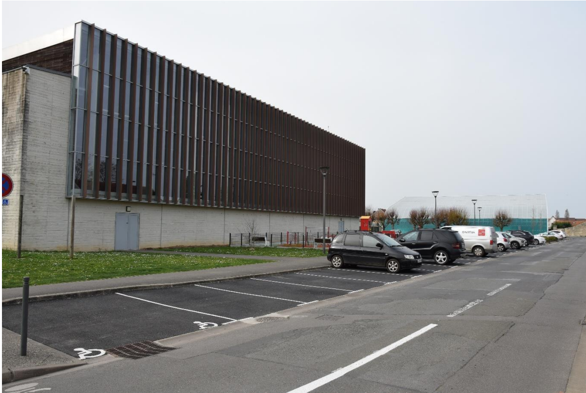
Rue du stade : réfection des places de stationnement
